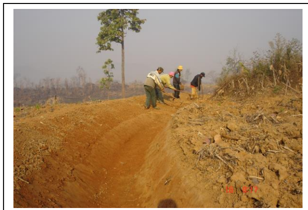
ภาพที่ 33 คันดินเบนน้ำ (Diversion)
