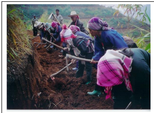
ภาพที่ 30 การก่อสร้างระบบอนุรักษ์ดินและน้ำโดยใช้แรงคน
