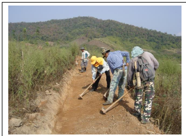
ภาพที่ 32 การตบแต่งระบบอนุรักษ์ดินและน้ำโดยใช้แรงคน
