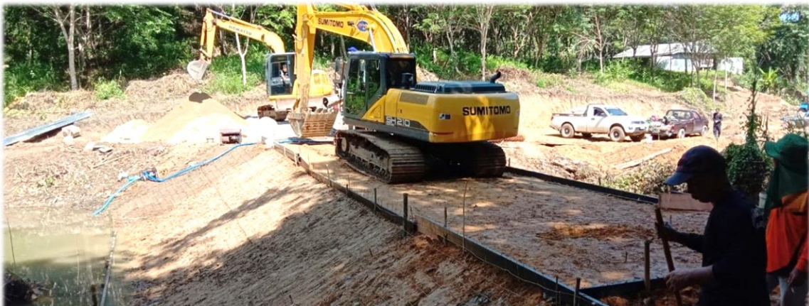
งานก่อสร้างฝายน้ำล้นคอนกรีตเสริมเหล็ก ขนาด 5.00x 15.00 x 2.00 เมตร 1 ตัว
