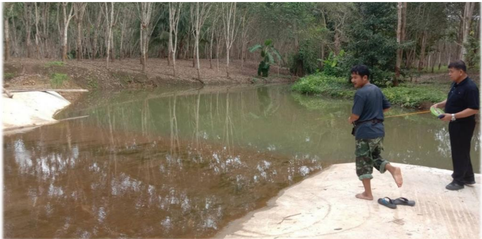
งานก่อสร้างฝายน้ำล้นคอนกรีตเสริมเหล็ก ขนาด กว้าง 5.00 x ยาว 15.00 x ลึก 2.50 เมตร
