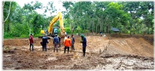
งานก่อสร้างฝายน้ำล้นคอนกรีตเสริมเหล็ก ขนาด 5.00 x 20.00 x 2.00 เมตร 1 ตัว
