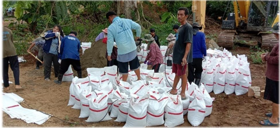
งานก่อสร้างฝาย Siol Cement ขนาด 5.00 x 11.60 x 1.20 เมตร 1 ตัว และ ขนาด 5.00 x 14.60 x 1.20 เมตร รวมทั้งหมด 2 ตัว
