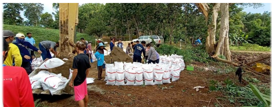
งานก่อสร้างฝาย Siol Cement ขนาด 5.00 x 11.60 x 1.20 เมตร 1 ตัว และ ขนาด 5.00 x 14.60 x 1.20 เมตร รวมทั้งหมด 2 ตัว
