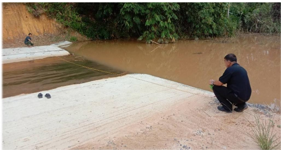
งานก่อสร้างฝายน้ำล้นคอนกรีตเสริมเหล็ก ขนาด กว้าง ๕.๐๐ x ยาว ๒๐.๐๐ x ลึก ๒.๐๐ เมตร
