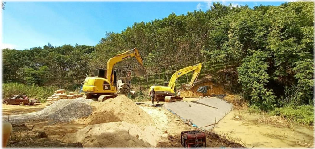
งานก่อสร้างฝายน้ำล้นคอนกรีตเสริมเหล็ก ขนาด 5.00 x 20.00 x 2.00 เมตร
