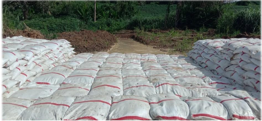
งานก่อสร้างฝาย งานก่อสร้างฝาย Soil Cement ขนาด 5.00 x 11.60 x 1.20 เมตร 1 ตัว
