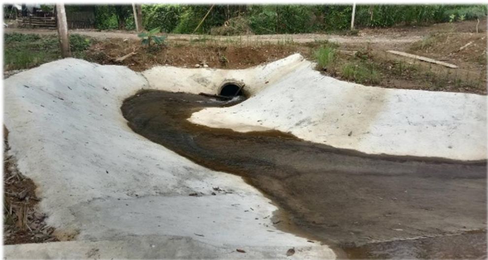
งานก่อสร้างฝายน้ำล้นคอนกรีตเสริมเหล็ก ขนาด 5.00 x 15.00 x 2.00 เมตร 1 ตัว
