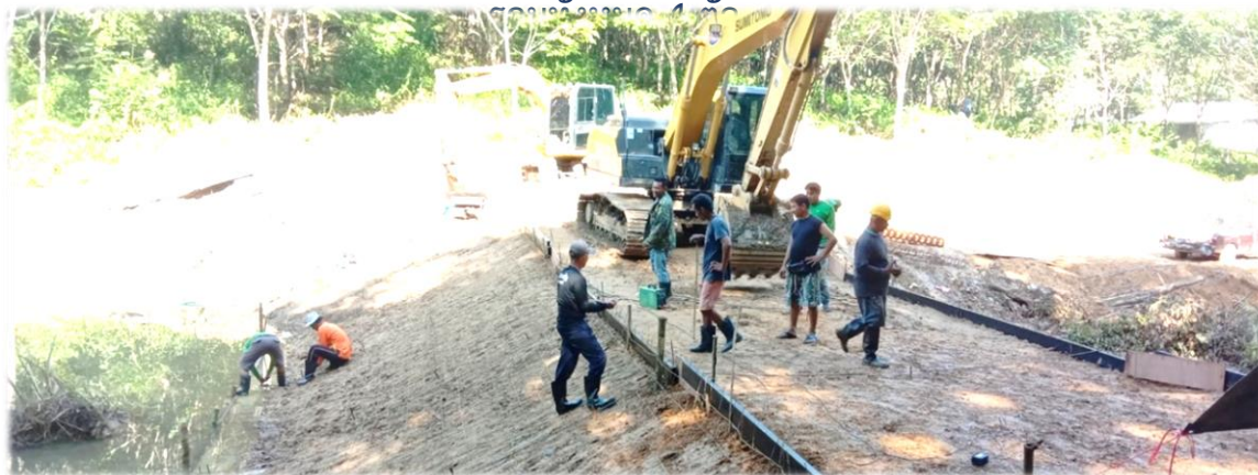
งานก่อสร้างฝายน้ำล้นคอนกรีตเสริมเหล็ก ขนาด 5.00 x 15.00 x 2.00 เมตร 2 ตัว ขนาด 5.00x 15.00 x 2.50 เมตร 1 ตัว ขนาด 5.00x 20.00 x 2.00 เมตร 1 ตัว
