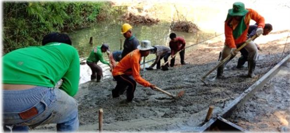
งานก่อสร้างฝายน้ำล้นคอนกรีตเสริมเหล็ก ขนาด 5.00 x 20.00 x 2.00 เมตร 1 ตัว
