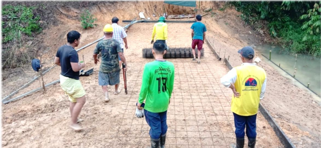
งานก่อสร้างฝายน้ำล้นคอนกรีตเสริมเหล็ก ขนาด 5.00 x 15.00 x 2.00 เมตร 2 ตัว ขนาด 5.00x 15.00 x 2.50 เมตร 1 ตัว ขนาด 5.00x 20.00 x 2.00 เมตร 1 ตัว
