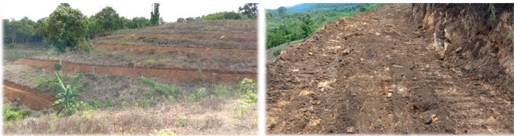
งานก่อสร้างคันดิน แบบที่ 5 (คูรับน้ำขอบเขา) รวมระยะทาง 4,000 เมตร
