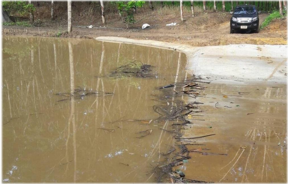
งานก่อสร้างฝายน้ำล้นคอนกรีตเสริมเหล็ก ขนาด กว้าง 5.00 x ยาว 15.00 x ลึก 2.50 เมตร
