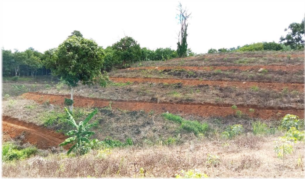
งานก่อสร้างคันดิน แบบที่ 5 (คูรับน้ำขอบเขา) รวมระยะทาง 4,000 เมตร
