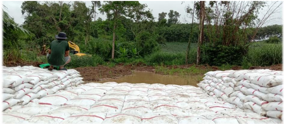
งานก่อสร้างฝาย งานก่อสร้างฝาย Soil Cement ขนาด 5.00 x 11.60 x 1.20 เมตร 1 ตัว
