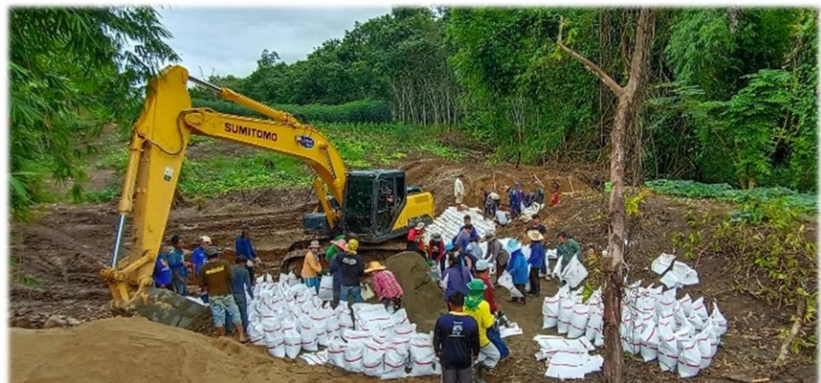
งานก่อสร้างฝาย Siol Cement ขนาด 5.00 x 11.60 x 1.20 เมตร 1 ตัว และ ขนาด 5.00 x 14.60 x 1.20 เมตร รวมทั้งหมด 2 ตัว
