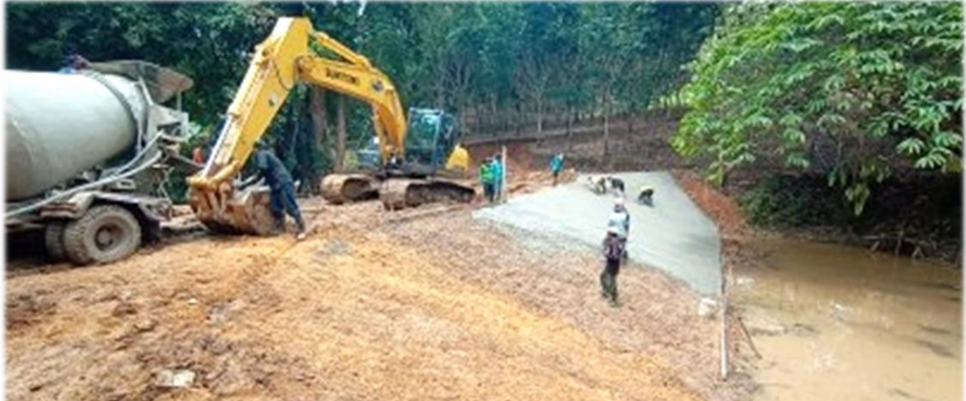
งานก่อสร้างฝายน้ำล้นคอนกรีตเสริมเหล็ก ขนาด 5.00 x 20.00 x 2.00 เมตร 1 ตัว
