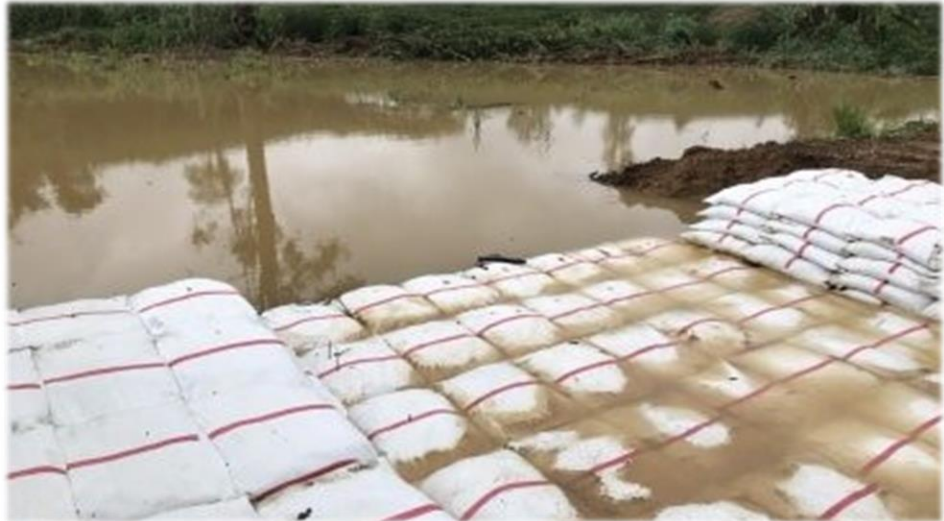
งานก่อสร้างฝาย Soil Cement ขนาด 5.00 x 14.60 x 2.00 เมตร 1 ตั้ว
