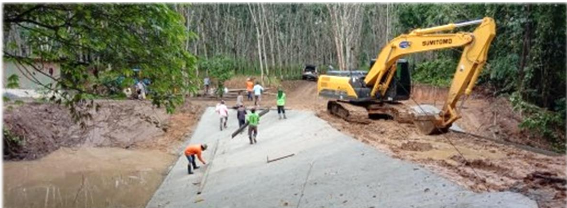
งานก่อสร้างฝายน้ำล้นคอนกรีตเสริมเหล็ก ขนาด 5.00x 15.00 x 2.00 เมตร 1 ตัว
