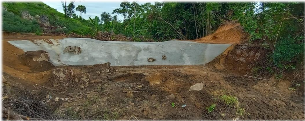
งานก่อสร้างฝายน้ำล้นคอนกรีตเสริมเหล็ก ขนาด 5.00 x 20.00 x 2.00 เมตร
